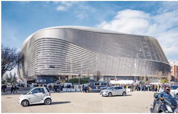
Remodelación del Estadio Santiago Bernabéu
