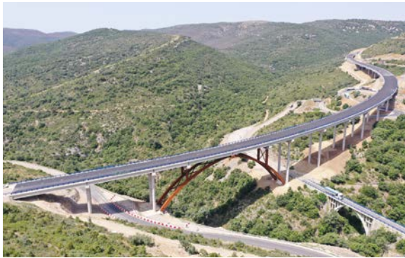
Viaducto sobre el Barranco de la Bota
