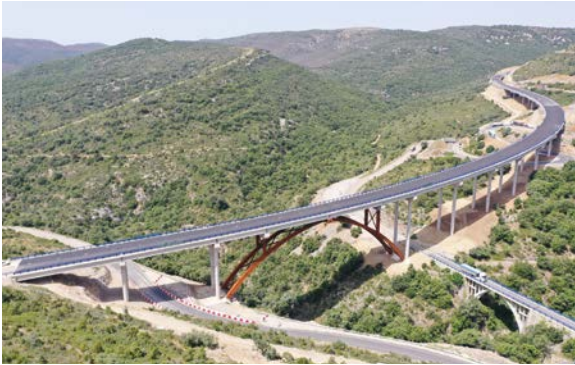
Viaduct over Barranco de la Bota
