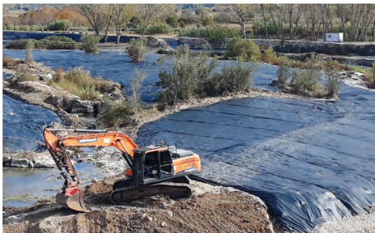
Restauración de los cauces del Júcar
