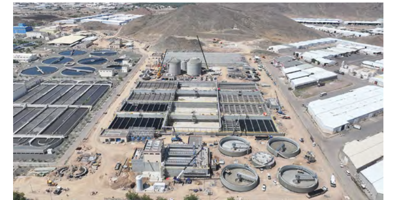
Planta depuradora de Medinah, Arabia Saudí
