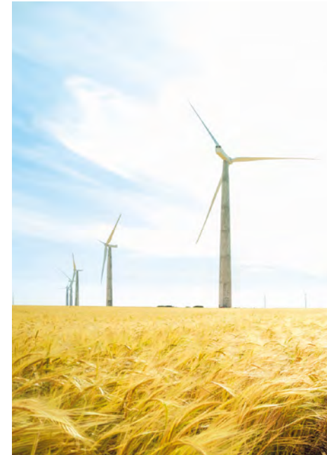
Planta eólica preexistente de Gecama, Minglanilla, Cuenca
