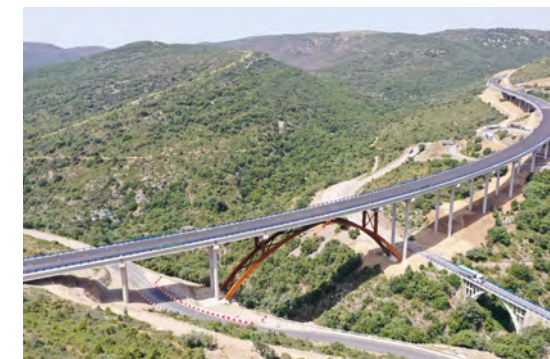
Viaducto sobre el Barranco de la Bota
