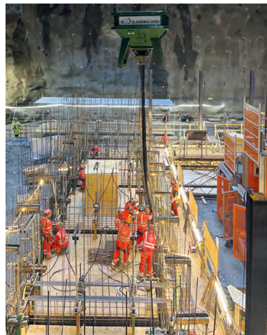
Obras del Metro de Estocolmo. Línea Azul
