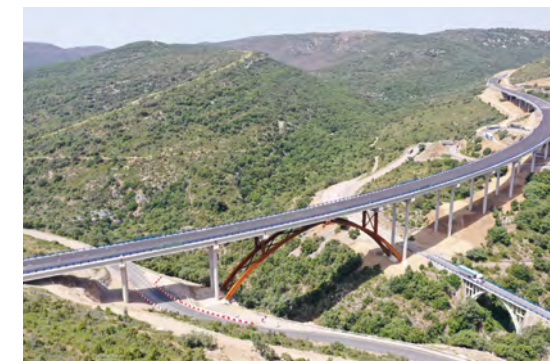
Viaduct over the Barranco de la Bota
