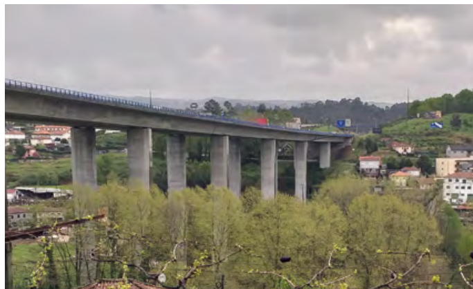
Nueva línea ferroviaria Vale do Sousa, Portugal
