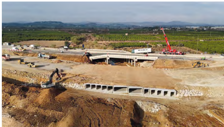
Autovía A-7. Rehabilitación de infraestructuras afectadas por la DANA, Valencia
