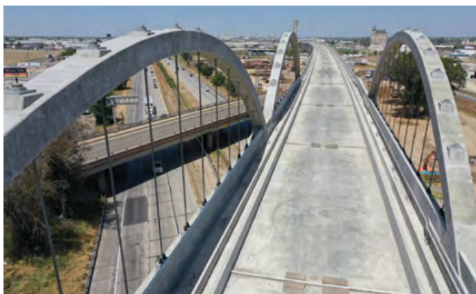
Obras de la primera línea de alta velocidad en California, EE. UU.
