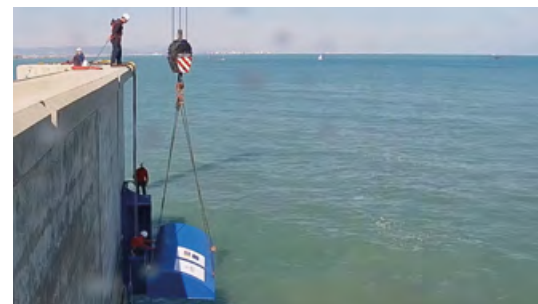
Instalación del dispositivo de energía undimotriz en el puerto de Valencia
