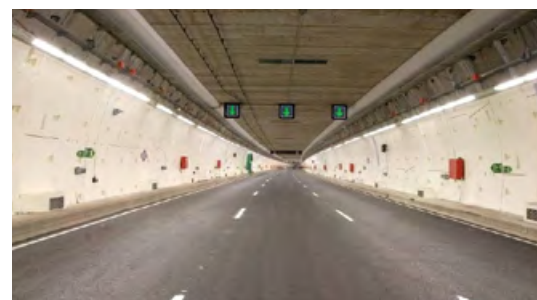
By-Pass Sur. Soterramiento de la vía urbana M-30, Madrid
