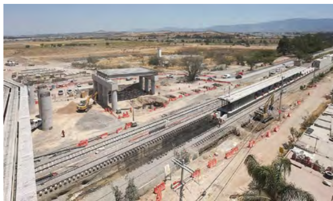
Obras de la estación de El Cuervo y acceso a glorieta elevada. Metro de Guadalajara, México
