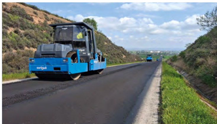
Renovación del firme en la Red Autonómica Aragonesa, España
