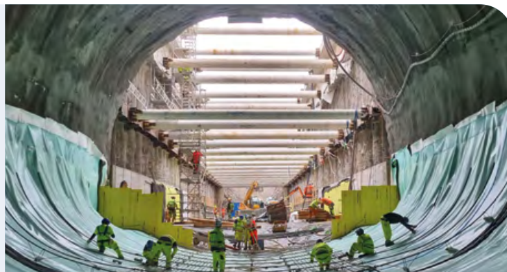
Obras del túnel ferroviario de Drammen. Noruega
