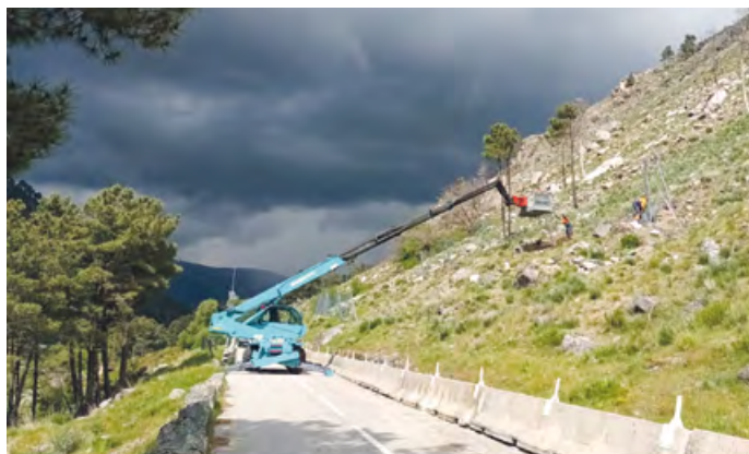
Actuaciones para el mantenimiento de carreteras en Portugal
