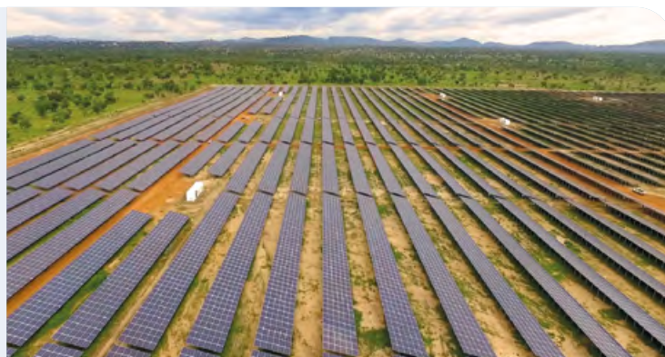
Planta solar de Zagtoui. Uagadugú, Burkina Faso
