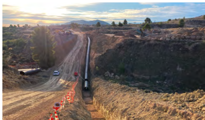
Obras de conducción del postravase Júcar-Vinalopó
