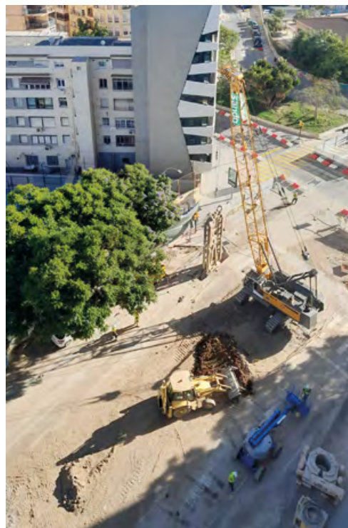
Obras de ampliación de la línea 2 del metro de Málaga
