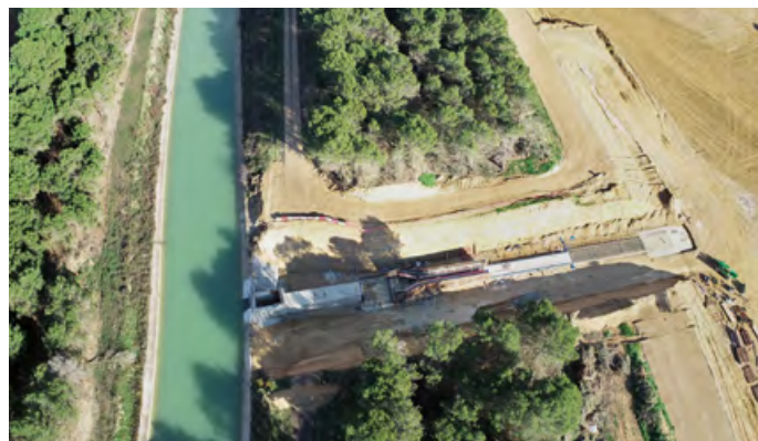
Obras de la balsa de regulación en el canal de Bardenas, Zaragoza
