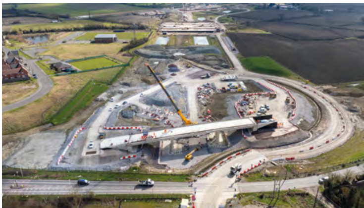
Reconfiguración de la carretera B441 por la construcción del puente Kinton para la integración de la infraestructura ferroviaria del HS2
