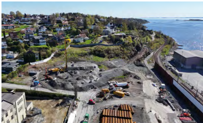
Obras de la estación de Moss, Noruega. Imagen: © Bane Nor
