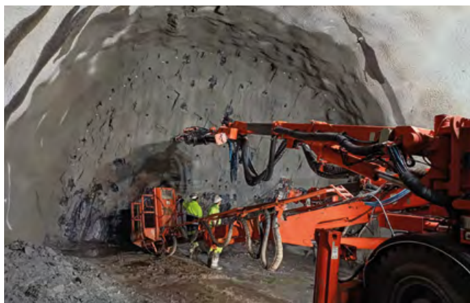
Obras de la línea 5 del metro de Bilbao. Tramo Galdakao-Hospital
