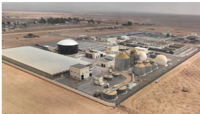
Planta depuradora de Tabuk-2, Arabia Saudí
