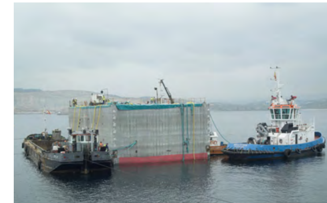
Transport of caissons in Punta Langosteira, A Coruña, Spain
