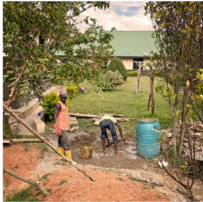
Obras de abastecimiento de agua potable en UNILAC
