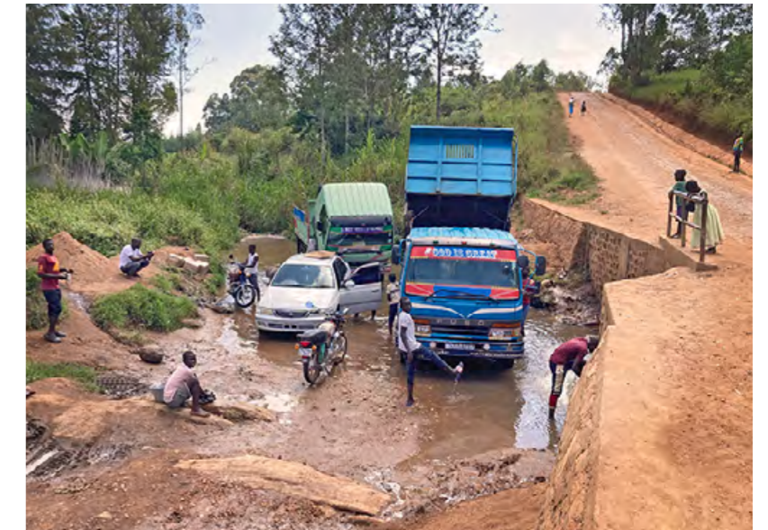
Obras de mejora en la carretera de acceso a UNILAC
