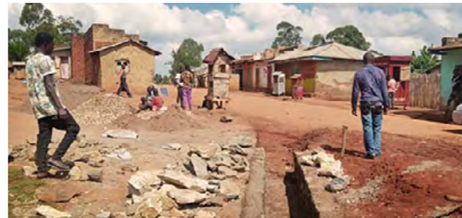
Obras adicionales de la carretera de acceso a UNILAC
