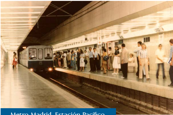
Metro Madrid. Estación Pacífico.
