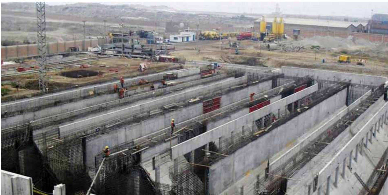
Construcción de una planta de tratamiento de aguas residuales en Lima (Cobra)
