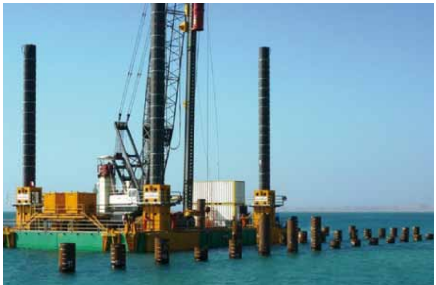
Nuevo Muelle de Contenedores del Terminal Portuario de Paita, en Piura
