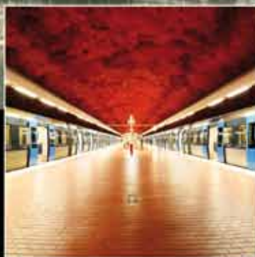
Metro de Estocolmo. Planificación y diseño de 11 km de línea con túnel en roca bajo el mar de Saltsjön
