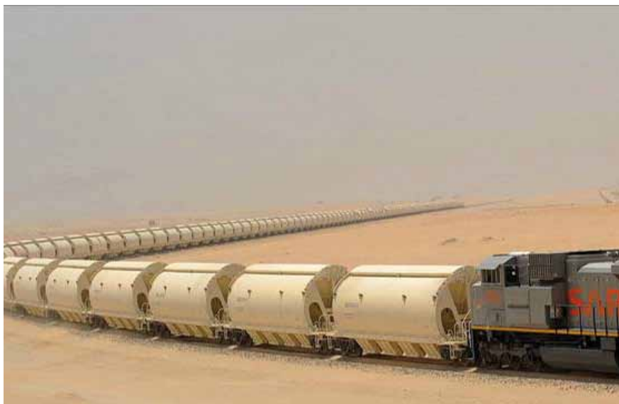
Construcción de líneas ferroviarias (Tysa)
