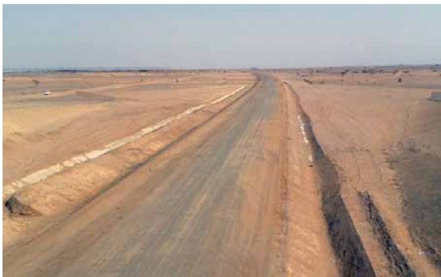
Terrenos de construcción del AVE (Cobra)
