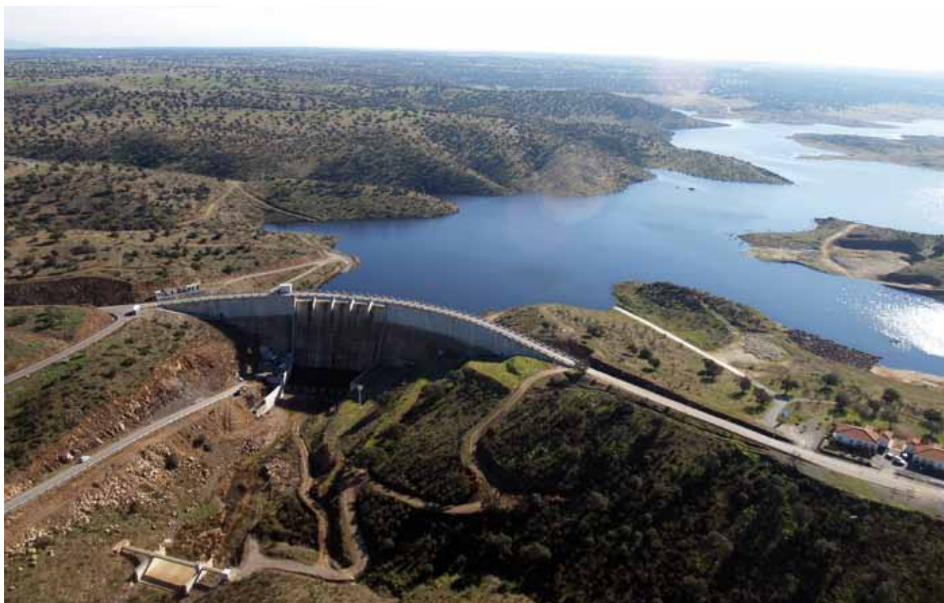
Presa de La Colada
