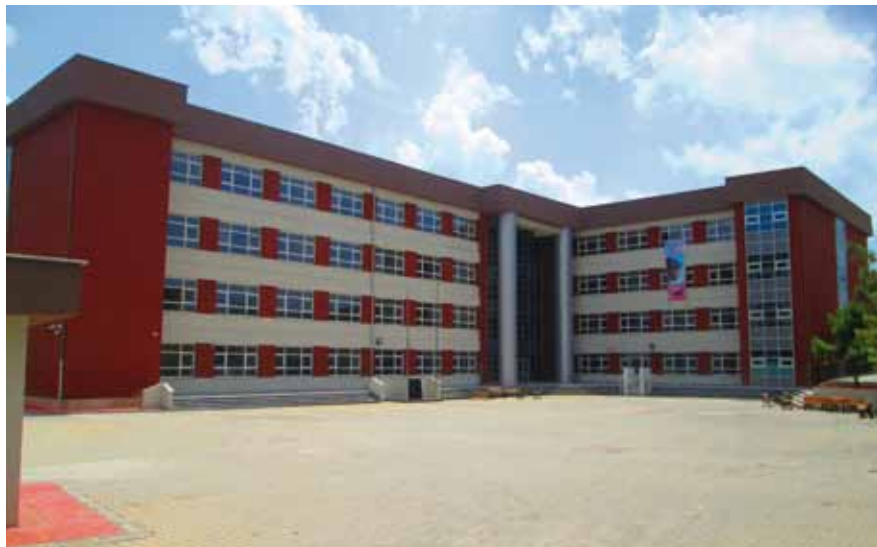
Supervisión de obra de 40 colegios en Estambul (Euroestudios)
