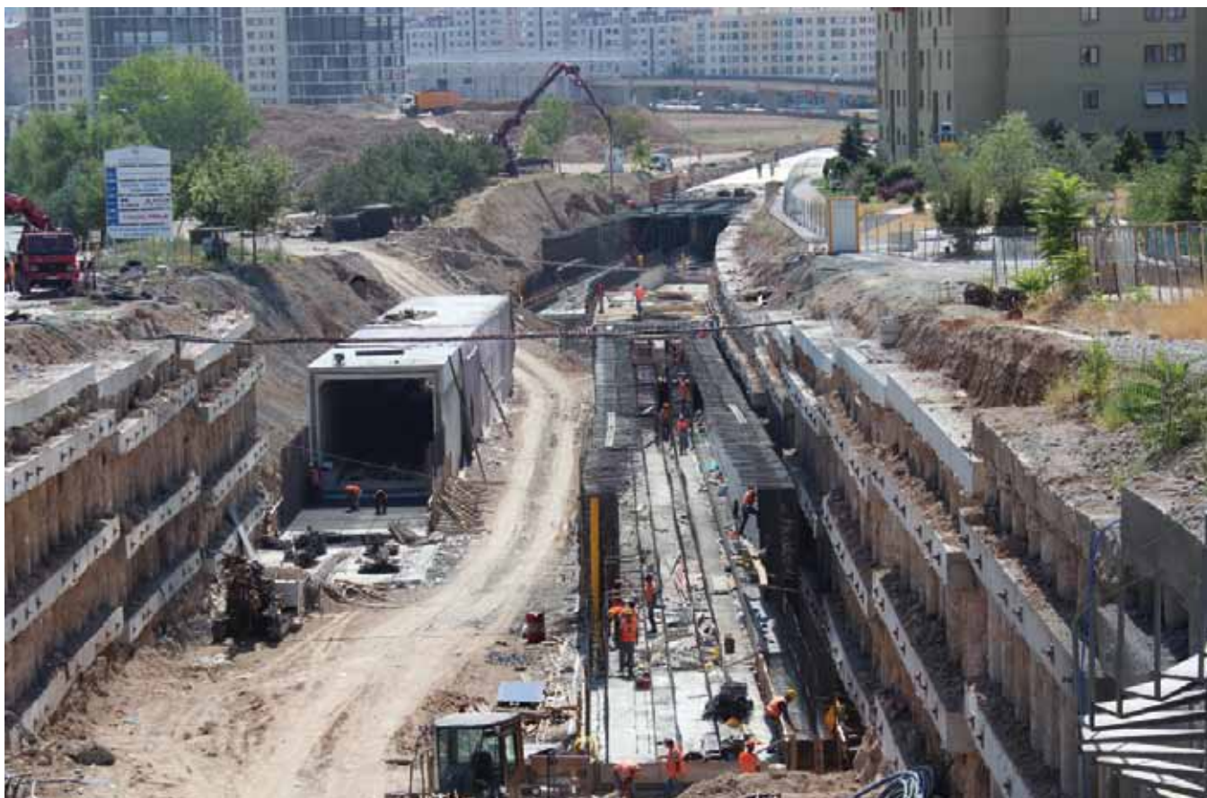
Obra del metro en Ankara (Comsa Emte)
