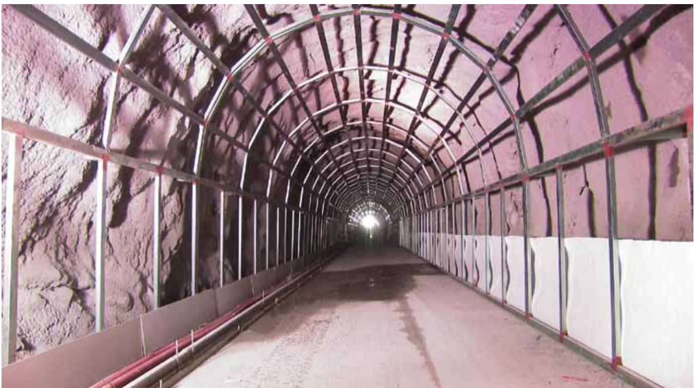
Túnel Sinaloense, carretera Durango-Mazatlán (FCC)
