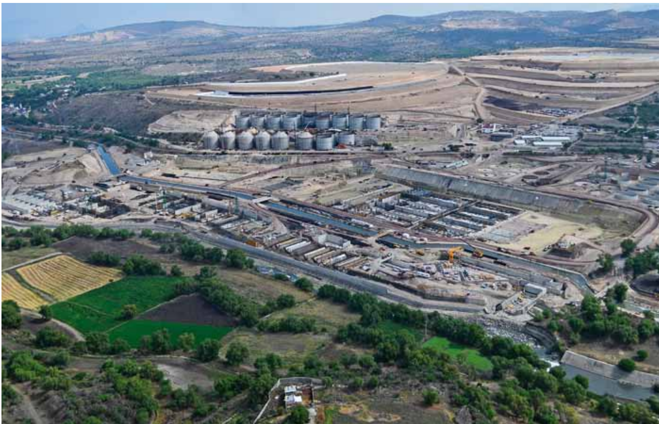
Planta depuradora de aguas residuales de Atotonilco (Tysa)
