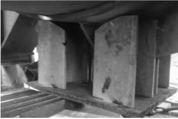
Figura 8. Gatos hidráulicos para izado de la estructura
