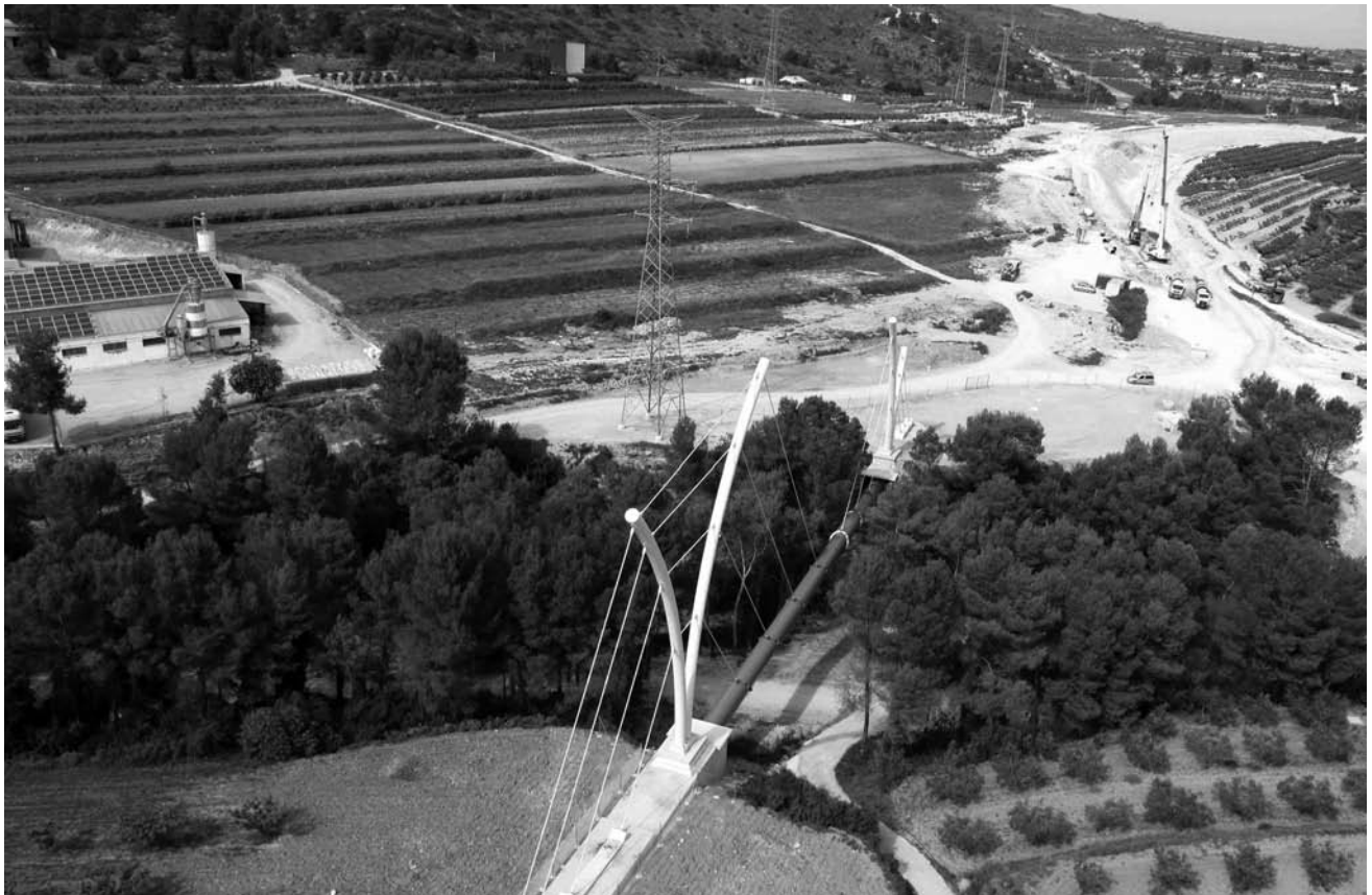
Figura 11. Vista aérea de la estructura terminada
