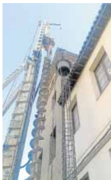
Trabajos de Pilotes y Obras.
