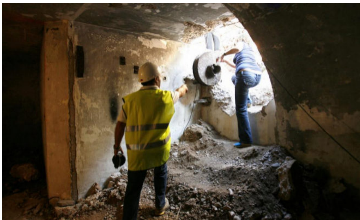
Antiguas obras iniciadas para la construcción de la línea T2 del metro, ahora línea 10. / ALBERTO DI LOLLI
