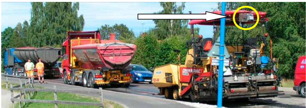
El escáner termográfico tipo Linjescanner montado en la parte trasera de la extendedora.
