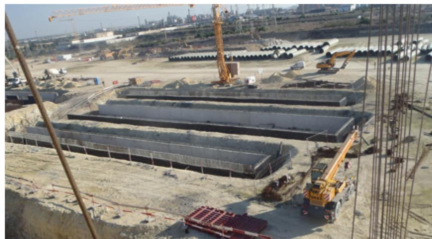
Edificio de ultrafiltración y una parte del edificio de ósmosis inversa. Zanja de la tubería de salmuera (GRP)
