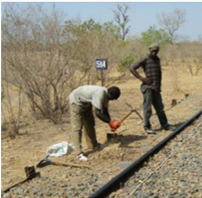
A partir del trabajo de campo realizado, se programó una campaña de investigación geotécnica que consistió en la ejecución de calicatas manuales en la plataforma de la vía y ensayos de penetración dinámica en los puentes. Durante el mes de abril, Álvaro Barrero se desplazó de nuevo a la zona, para coordinar y definir los criterios de la ejecución de la campaña. Estos trabajos de campo han exigido movilizar a un
