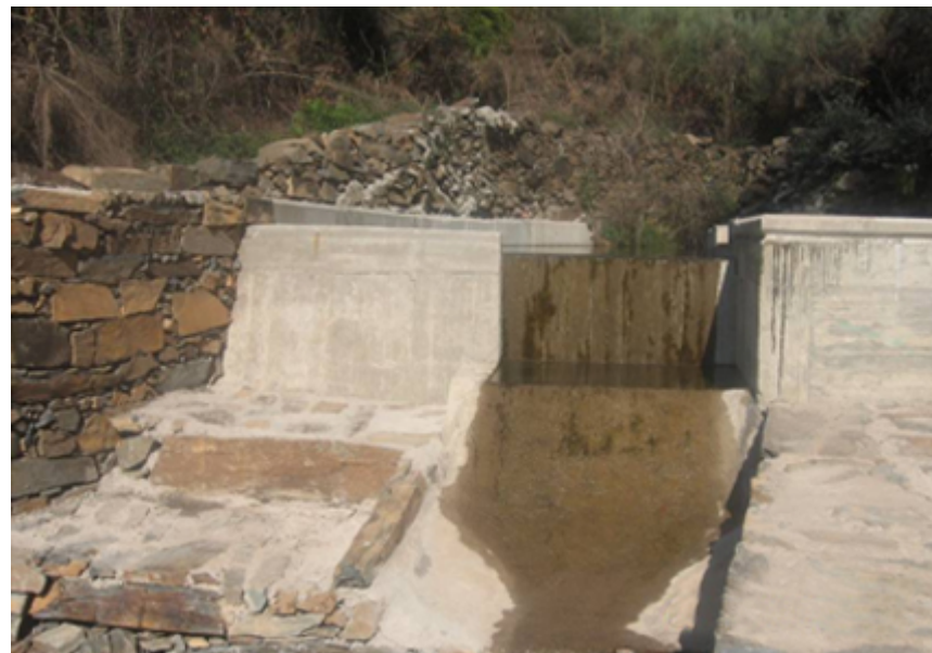
Azud ejecutado en el Arroyo Cotorro de la Roquera (Robledo).
