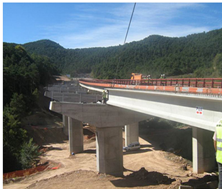
Viaducto de Pere Riera, con vigas prefabricadas
