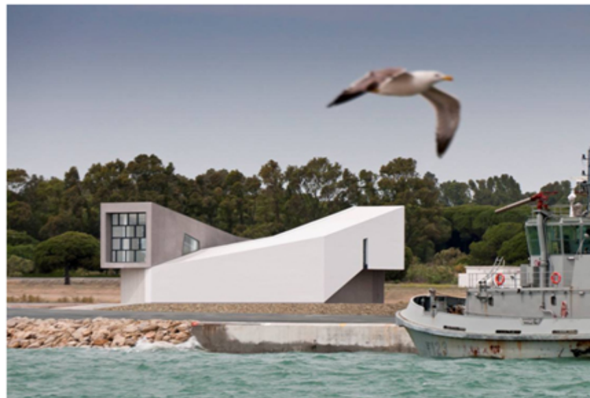
Edificio 2722 de Apoyo a las Instalaciones Portuarias
