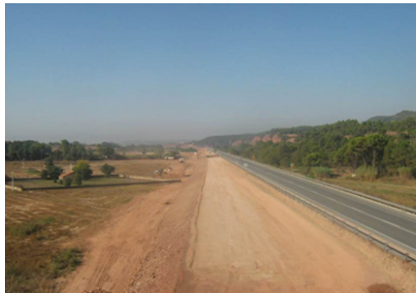
Vista general de tramo a a desdoblarse
