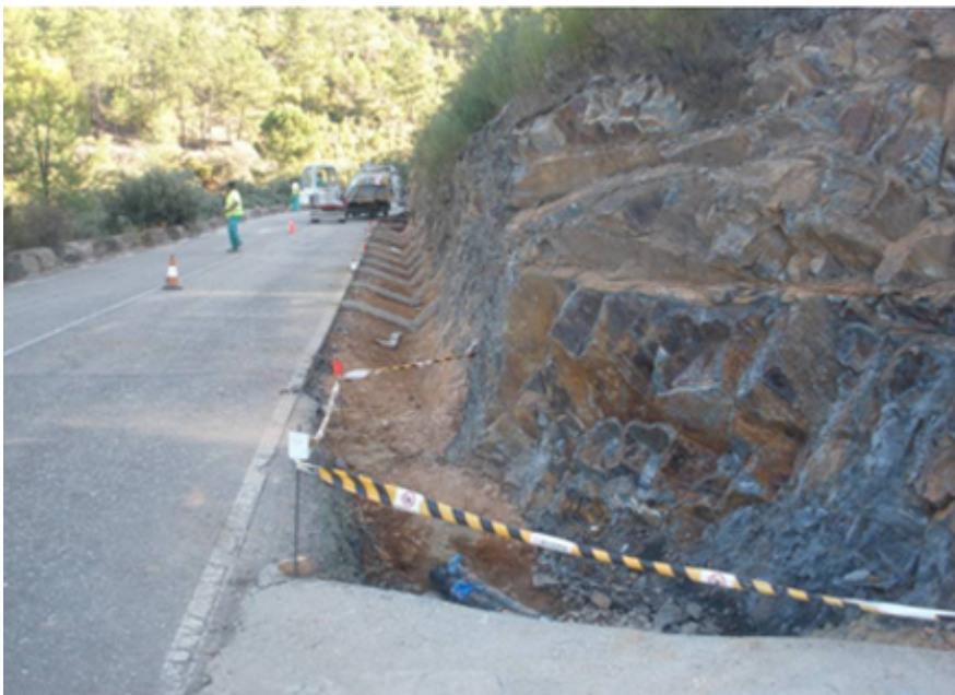
Conducción afectada por las exigencias de la Diputación de Cáceres
