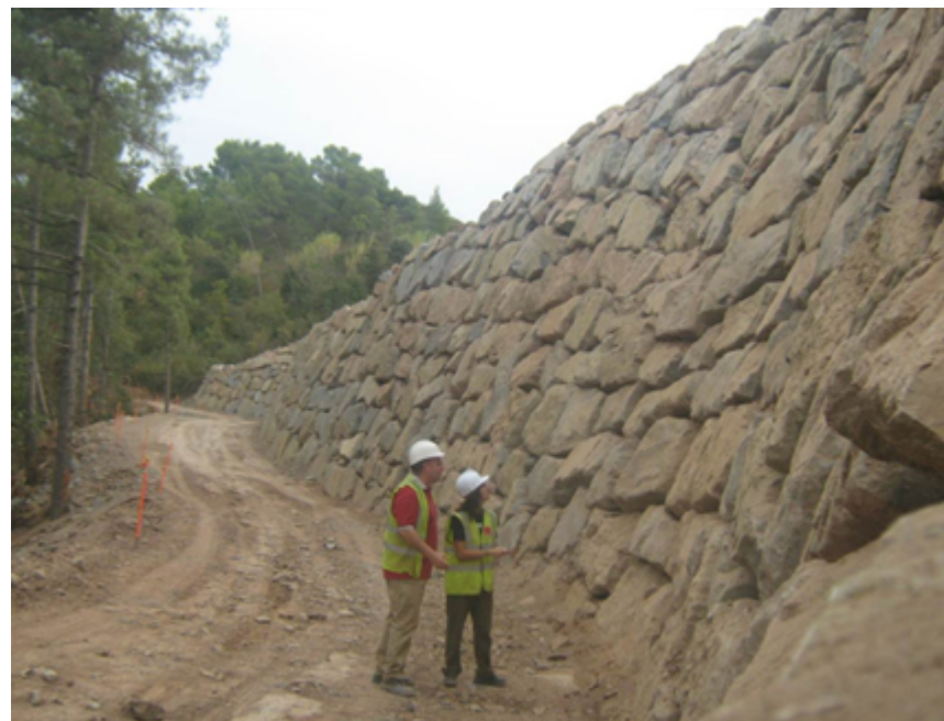
Personal de TYPESA en la obra
