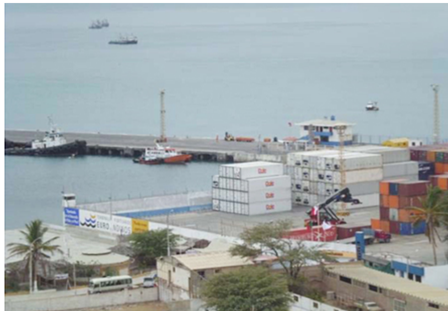
Puerto comercial actual - Muelle comercial y zona de almacenamiento
