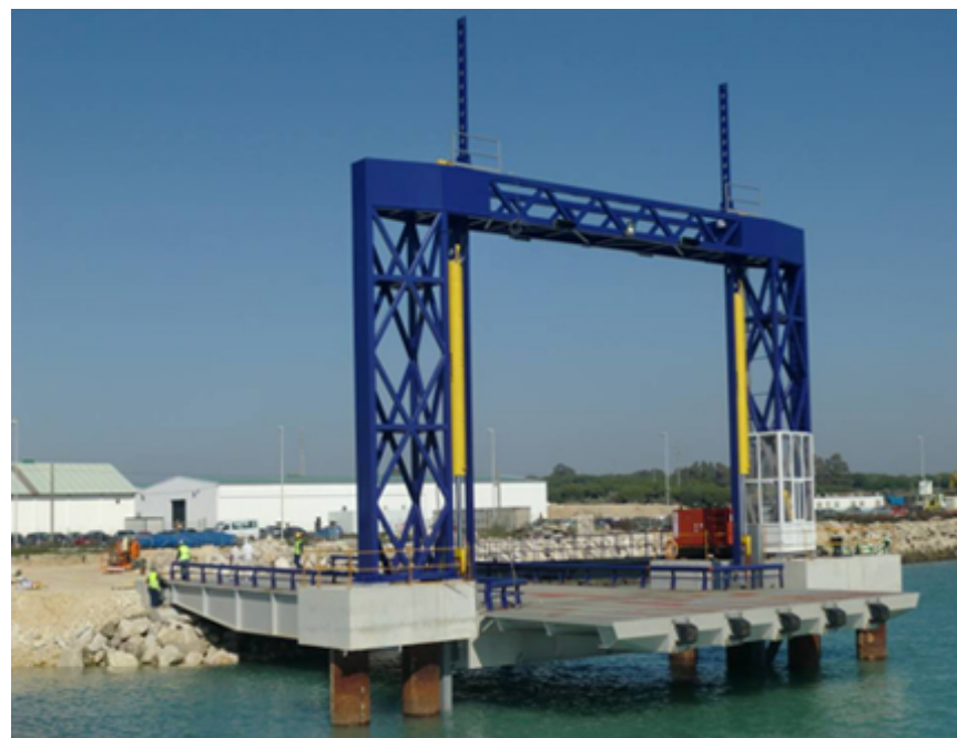
Rampa Ro-Ro situada en la Base Naval de Rota. Fotografía Mayo 2011
