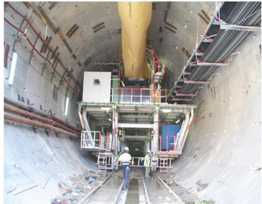
Vista del Back-up de la tuneladora al inicio de los trabajos de perforación.
