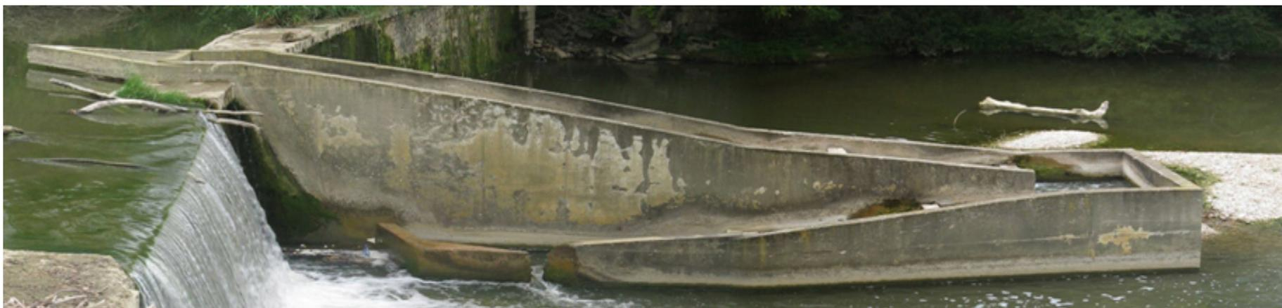
Escala de Peces de estanques sucesivos en la presa de la central de Satrústegui, en el río Arakil, Navarra
