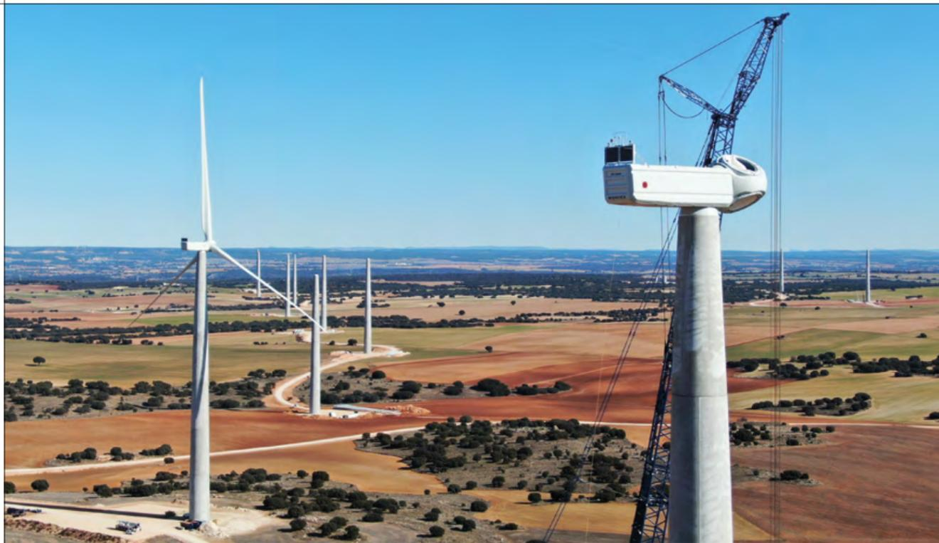
Ocupa un área aproximada de 8.000 ha y se ubica en la provincia de Cuenca, entre los municipios de Honrubia, Atalaya del Cañavate, Cañada Juncosa y Tébar. Consta de 69 aerogeneradores con una potencia de 4,8 MW cada uno. La torre es de hormigón y de una altura de 120 m hasta el buje que, sumado a su rotor de 149 m de diámetro, eleva la altura total del aerogenerador hasta los casi 200 m.
