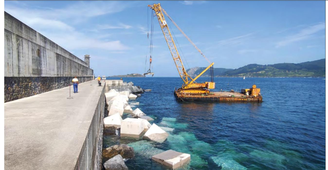
Entre los trabajos de supervisión, hay que destacar el refuerzo del dique de abrigo del puerto de Bermeo mediante bloques de hormigón de alta densidad, utilizando árido siderúrgico en su fabricación. El empleo de este tipo de hormigón tiene una componente medioambiental muy importante, ya que se reduce el consumo de árido calizo de cantera y se pone en valor un residuo de las acerías de horno eléctrico.
