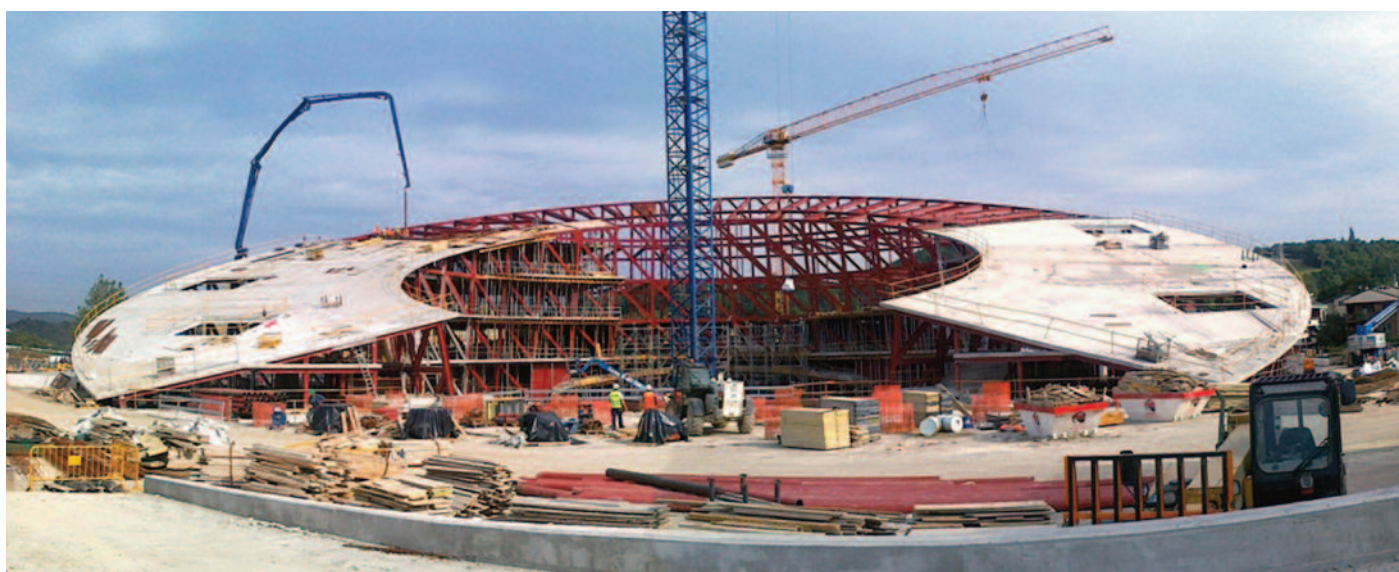
Edificio en fase de montaje de hormigonado de forjados
