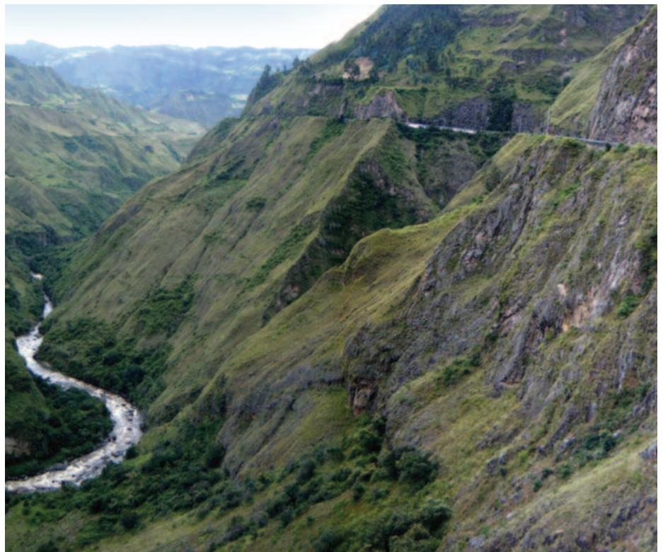
Paso actual de ruta nacional 25 a través del cañón del río Guáitara
