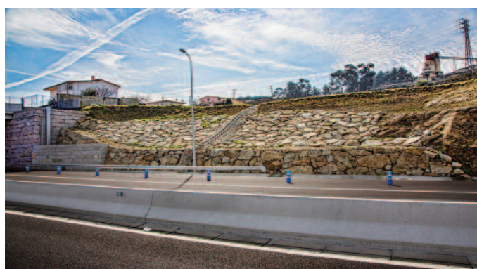
Sostenimiento con piel de escollera al inicio de tramo
