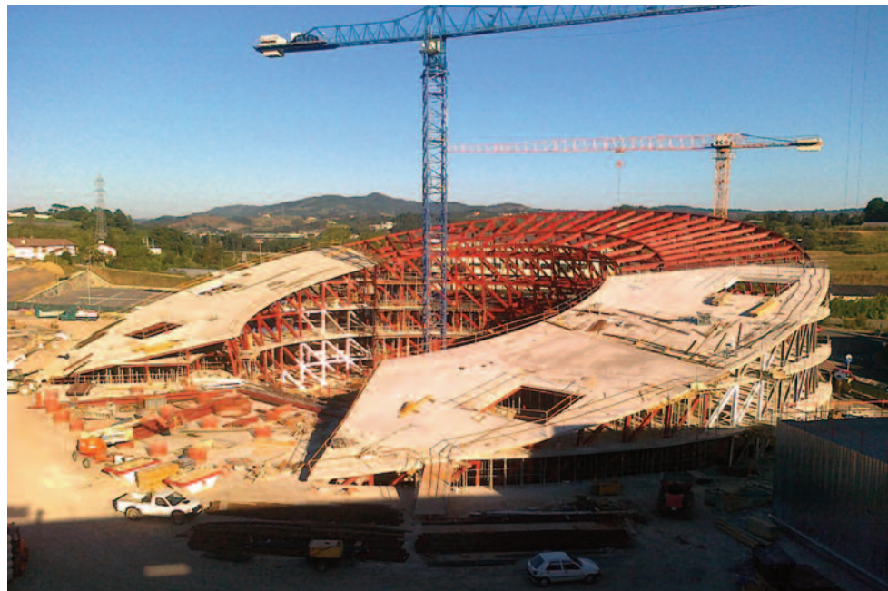
Edificio en fase de construcción
