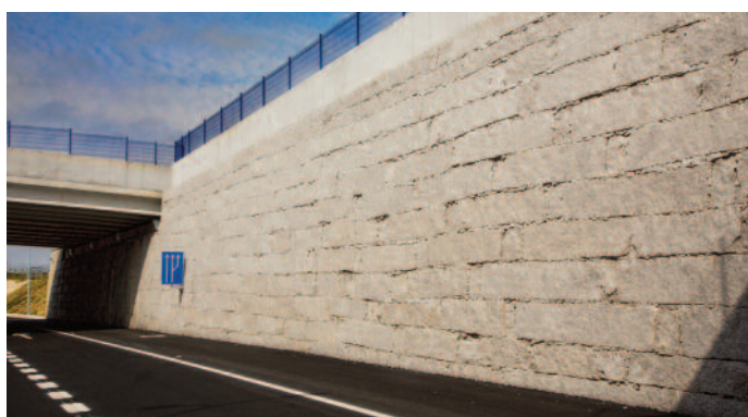
Espacio entre falsos túneles en la zona de As Rañas
