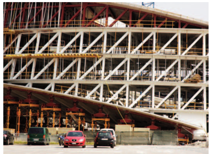
Celosías en construcción
