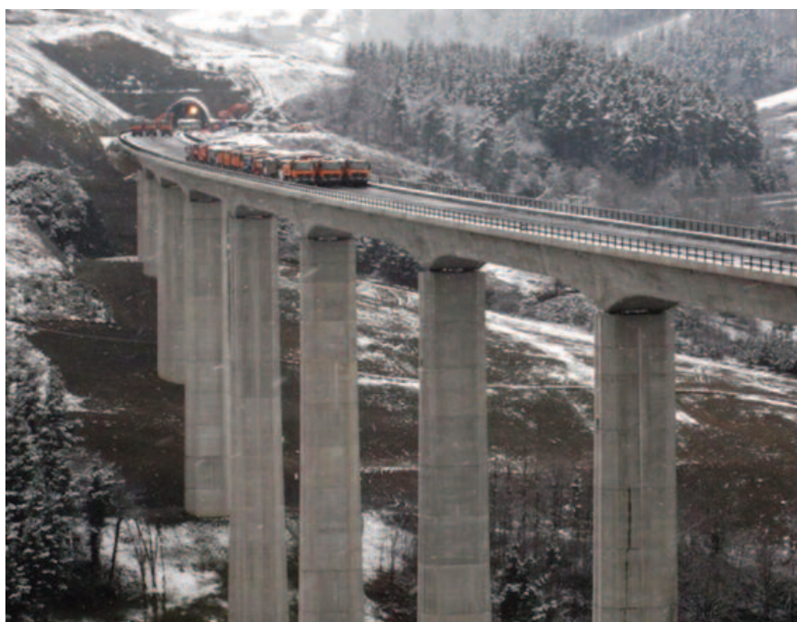
Prueba de carga estática en Viaducto Deba
