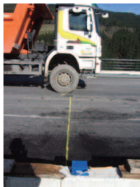
Paso sobre neoprenos
