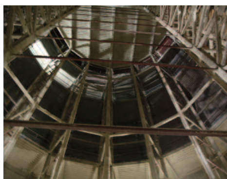
Estaciones profundas Línea 9. Metro Barcelona
