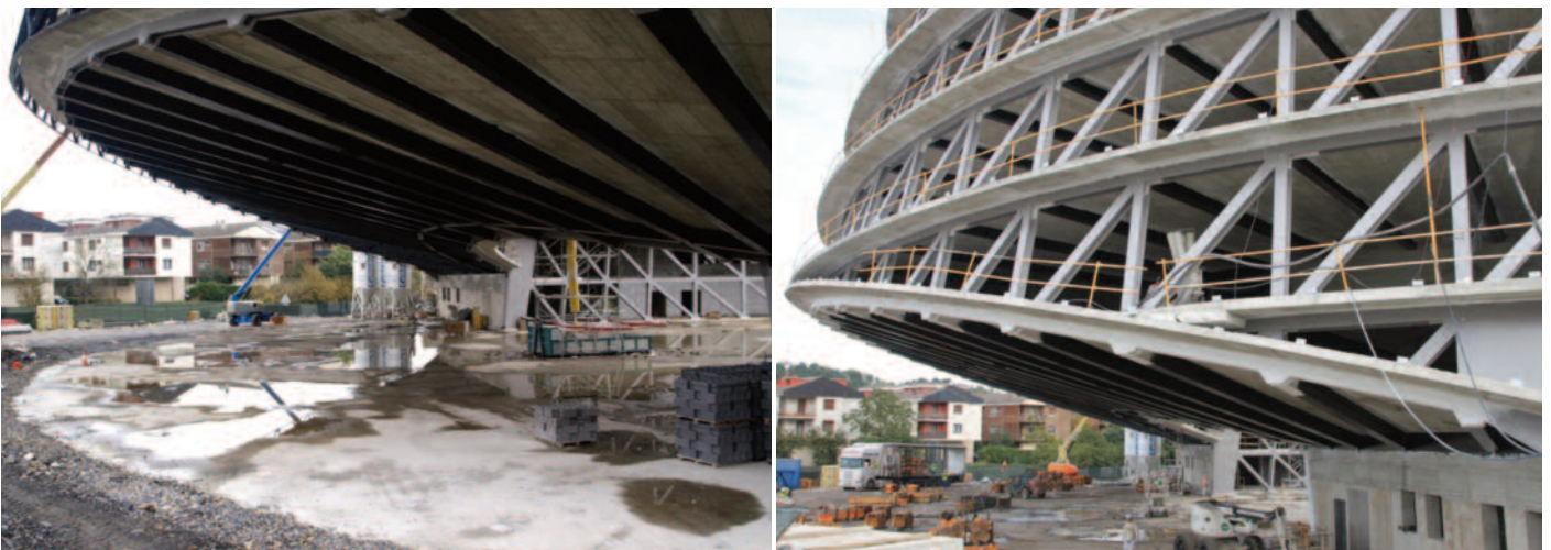
Zona inferior del voladizo tras el desapeo
