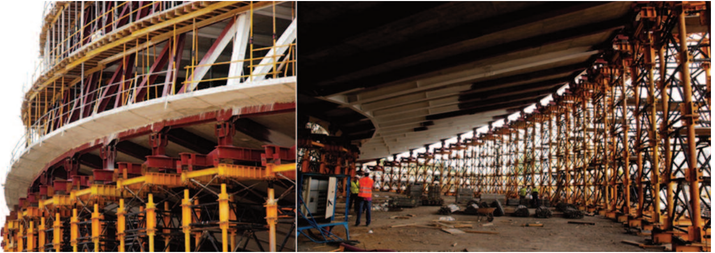
Edificio en fase de desapeo
