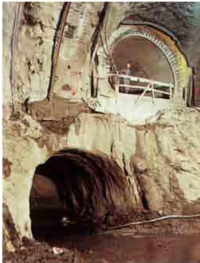
Fig. 7. Galerías laterales en una caverna de estación del Metro de Bilbao
